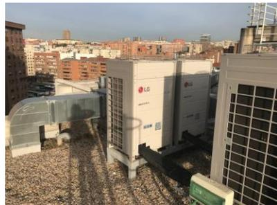
**Equipos exteriores** de condensación por aire, bomba de calor, que suministra fluido refrigerante a las **unidades interiores**
